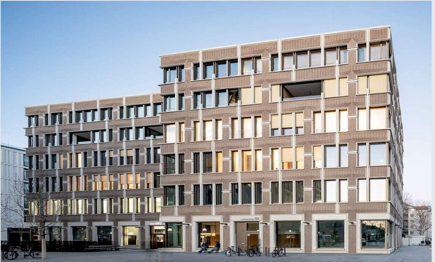
Klinker-Fertigteile sind werkseitig, unter gleichmäßig temperierten, optimierten hallenspezifischen Bedingungen hergestellte Architekturbetonelemente, deren Flächen teilweise oder ganz mit speziellen Formklinkern verkleidet sind. Dies ist sowohl bei Vorhang- als auch Sandwichelementen möglich.
