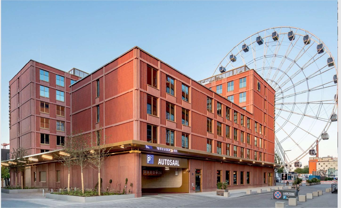
Bei den Sandwichelementen wird auf die eingelegten Klinker mit der entsprechenden Betonüberdeckung (Vorsatzschale) die geplante Wärmedämmung eingelegt. Beide Schichten werden statisch mit der Betontragschale verbunden. Das Sandwich-Element übernimmt die komplette Tragfunktion der Außenwand und ist als fix und fertiges Wandelement zu verstehen.
