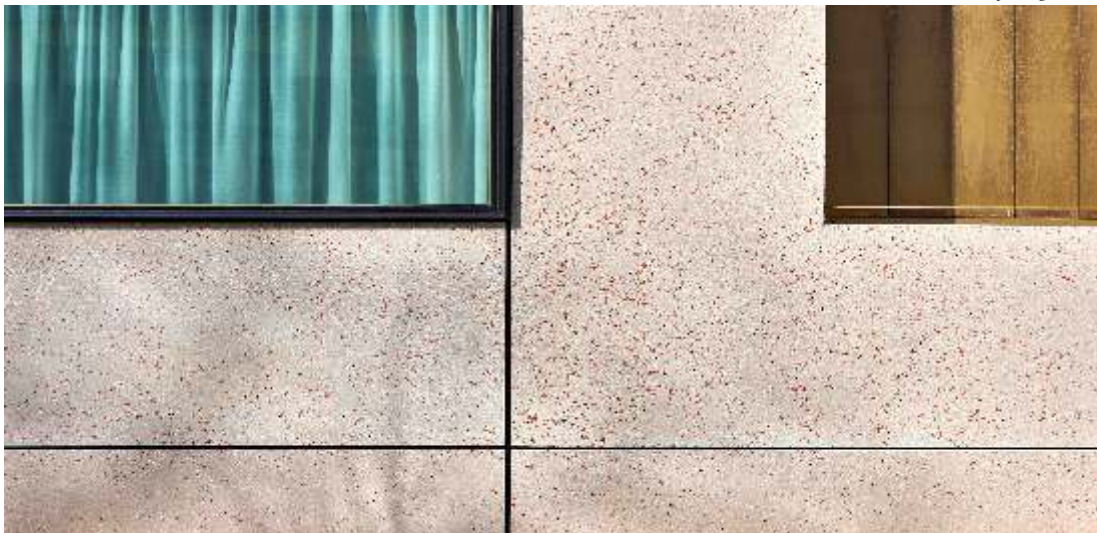
Fassade mit Recyclingbeton
