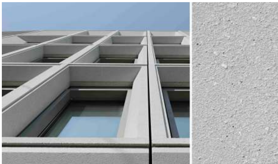
Referenz: Sichtberonfassade aus weißem Betonrahmen an einem Büro- und Wohngebäude in Basel
